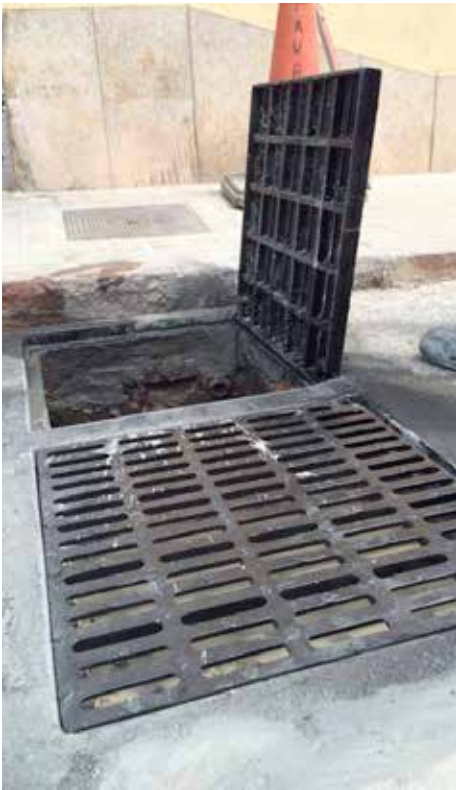
Actuació a la xarxa de clavegueram que consistirà en la substitució dels arrellons per anar millorant tota la xarxa del municipi.
