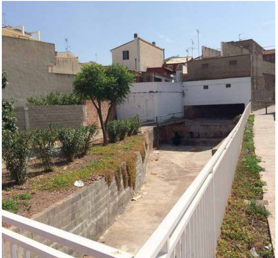
Restauració de la Canaleta, on es durà a terme una intervenció en la zona del barranc prop de l'Espai dels Majors.
