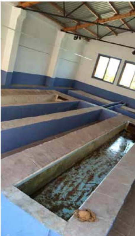
Amb el Pla d'Ocupació i una subvenció de 9.000 euros de la Diputació de València es restaurarà la cara interna de les sèquies del llavaner amb pedra natural. Les obres ja estan començades.
